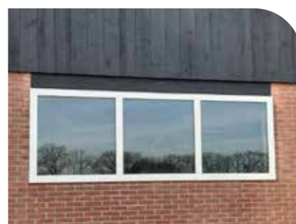
daglicht - ramen in de muur
